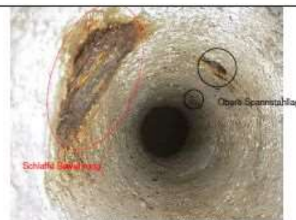
Brücke Achse B, Hohlrohr 1-1, Bild 1
