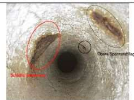
Brücke Achse B, Hohlrohr 1-1, Bild 2
